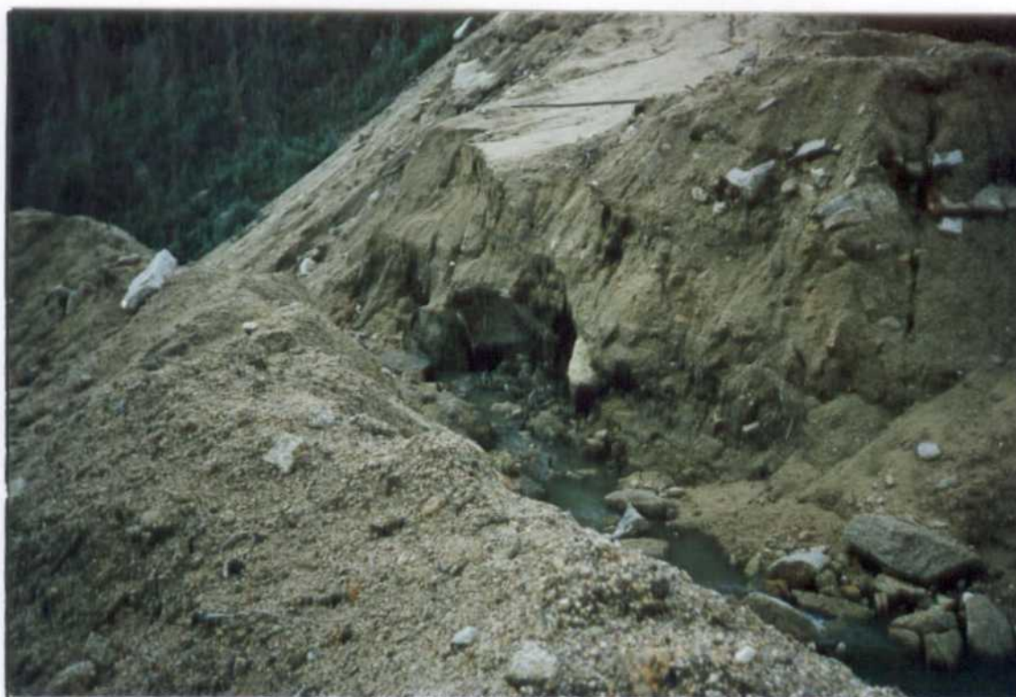
FOTO N° 9.- Ejemplo del mal emplazamiento correspondiente a la escombrera (4-11-8-12), formada por tierras de recubrimiento y situada en un cauce de agua.
