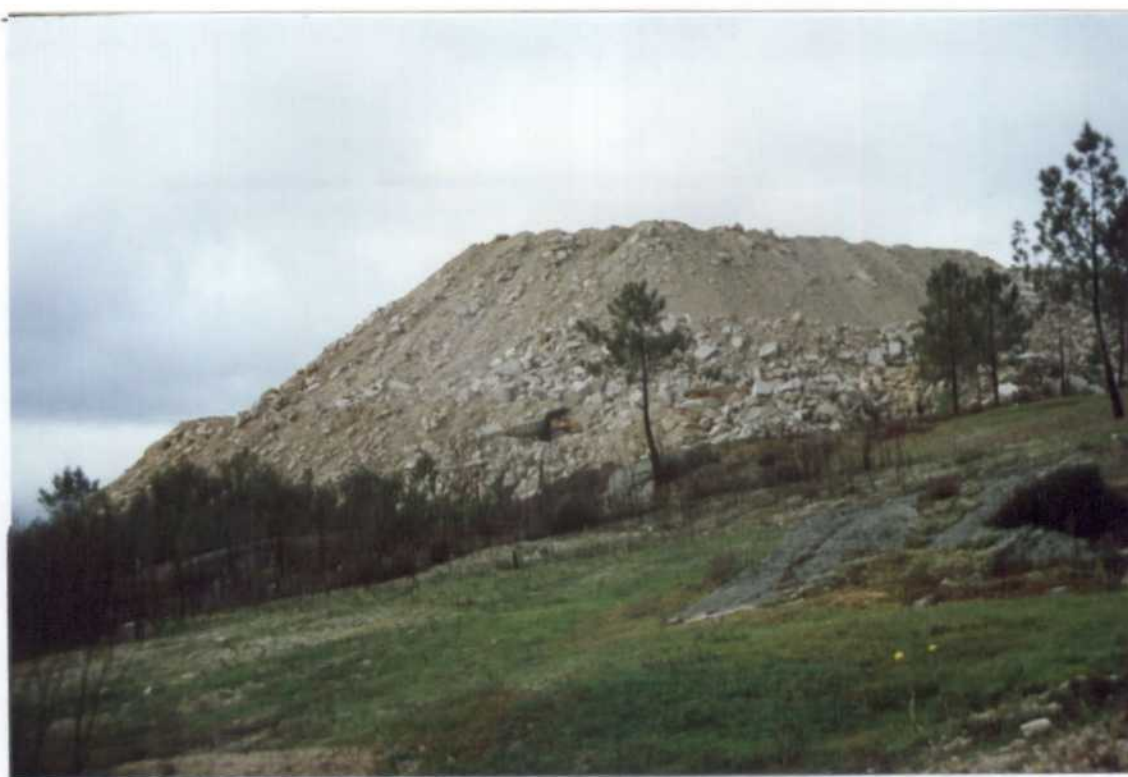
FCTO N° 8.- Escombrera (3-12-4-3) de la zona de Porriño, de más de 100.000 m 3 , formada por bloques de granito y tierras.
